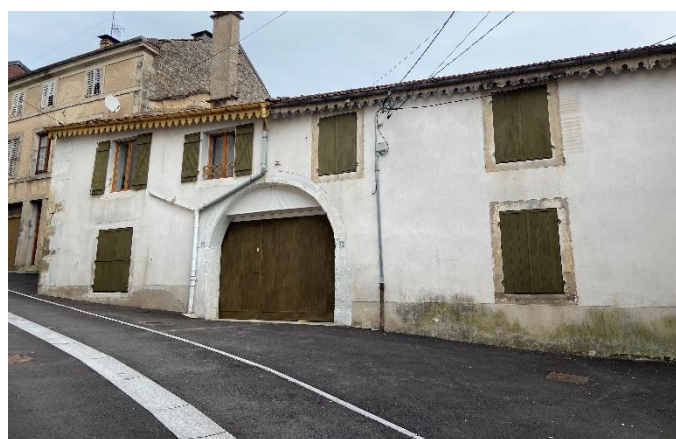
Avant/après d'une opération « Volets Repeints » en septembre 2021, avec les couleurs terre verte et terre verte antique
